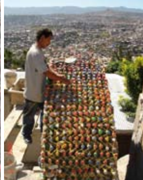
Construcción de tanques de almacenamiento de agua de hasta 16,000 lts. en diversos países de Latinoamérica.
