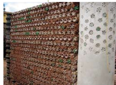
8. Detalle de la unión de un muro y un pilar hechos del "ladrillo plástico" en la construcción escolar en Diamante de Sión,
